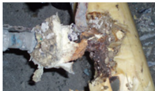
Undichte Fernwärmearmatur
